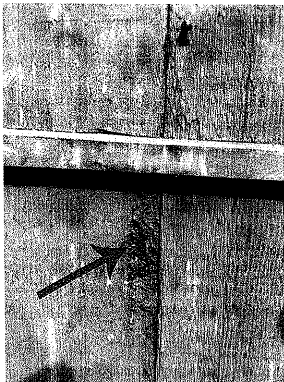
Fot. 6. Otwory wylotowe po kołatkach. Nieznacznie uszkodzona struktura drewna.
